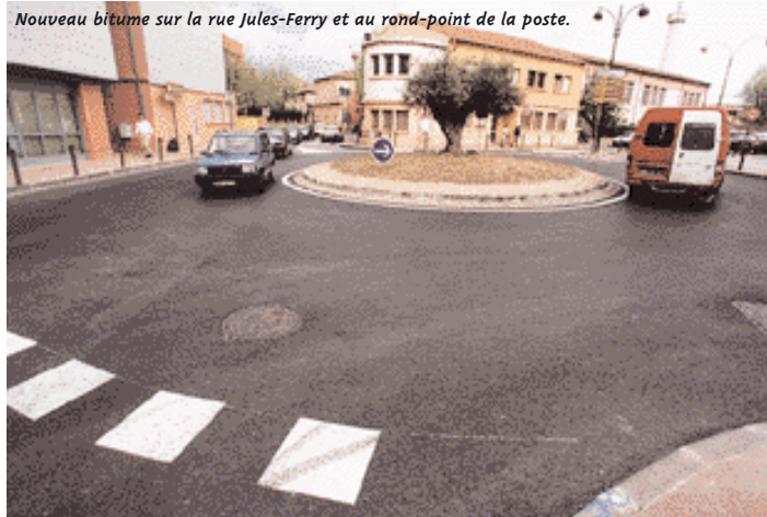
Nouveau bitume sur la rue Jules-Ferry et au rond-point de la poste.
